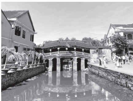
解体前の日本橋
